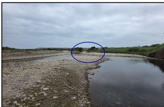
Se observa la sobcasi3n del dique y el desborde del caudal que afecta a 3rea de cultivo.
