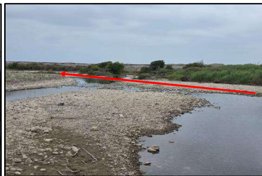
Punto final del tramo cr3tico la l3nea roja muestra la ubicaci3n donde se realizar3a la conformaci3n de los bordos con material propio del r3o.
